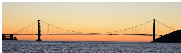
Cầu Golden Gate tại thành phố San Francisco, tiểu bang California, Hoa Kỳ { https://en.wikipedia.org/wiki/Golden_Gate_Bridge }
